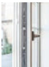
**Fermeture par crémonne encastrée** : intégrée dans un des vantaux, la crémonne est invisible et verrouille la fenêtre par action de la poignée.
